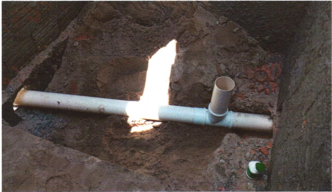
FOTO 11 - TUBO PVC, SÉRIE R, ÁGUA PLUVIAL, DN 100 MM, FORNECIDO E INSTALADO EM RAMAL DE ENCAMINHAMENTO. AF_06/2022
