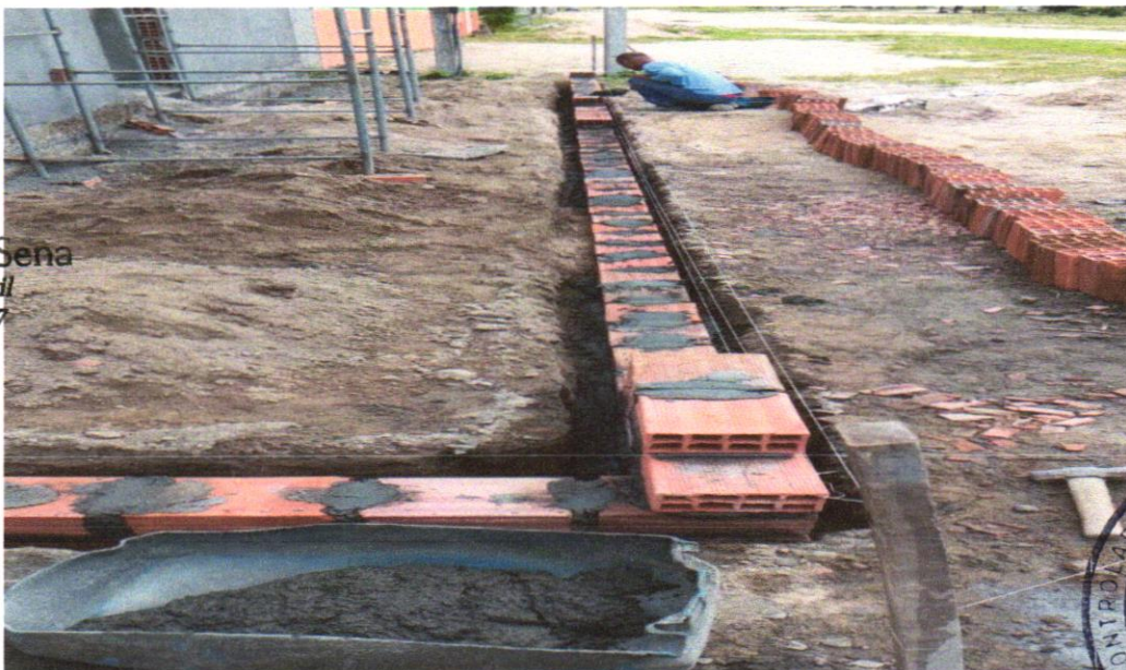
FOTO 02 – ALVENARIA DE VEDAÇÃO DE BLOCOS CERÂMICOS FURADOS NA VERTICAL, DE 9X19X39CM (ESPESSURA 9CM) DE PAREDES COM ÁREA LÍQUIDA MAIOR OU IGUAL A 6M 2 COM VÃOS E ARGAMASSA DE ASSENTAMENTO COM PREPARO EM BETONEIRA. AF 06/2014
