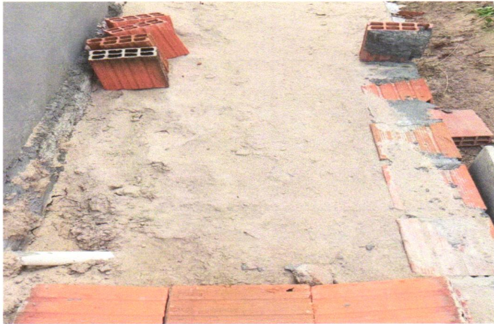
FOTO 03 - ATERRO MANUAL DE VALAS COM AREIA PARA ATERRO E COMPACTAÇÃO MECANIZADA. AF_05/2016
