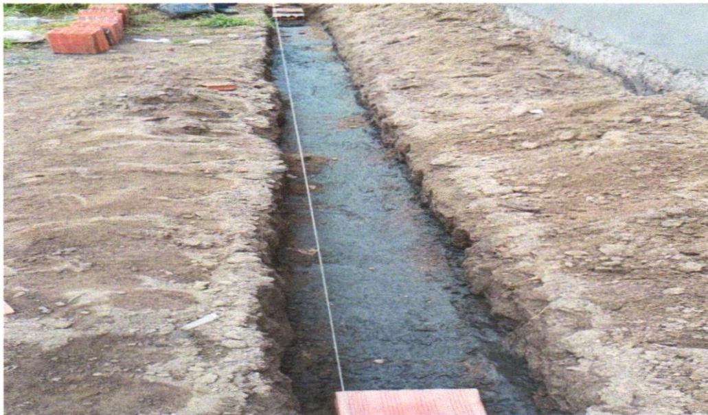
FOTO 01 – LASTRO DE CONCRETO MAGRO, APLICADO EM BLOCOS DE COROAMENTO OU SAPATAS, ESPESSURA DE 3 CM. AF_08/2017
