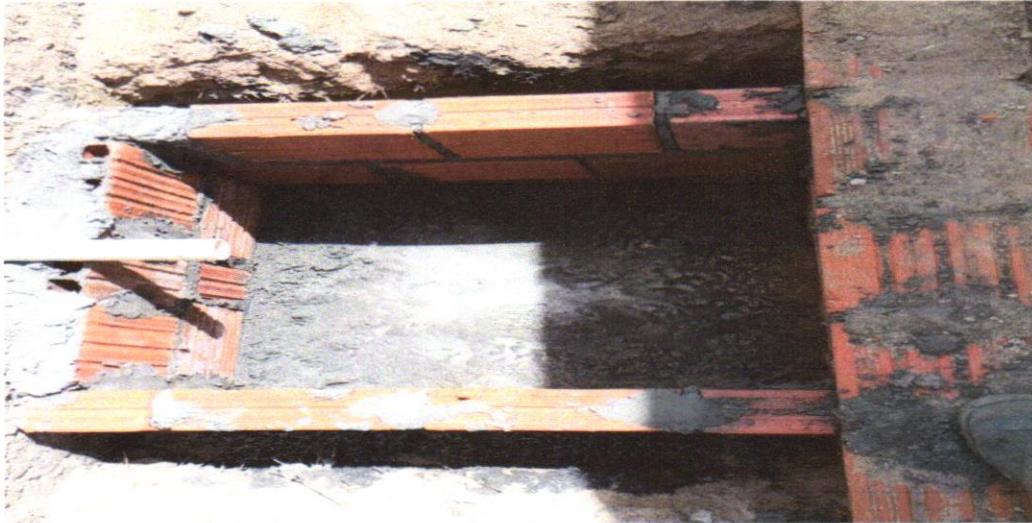
Foto 07 – Caixa de inspeção 0,30 x 0,30 x 0,40m
