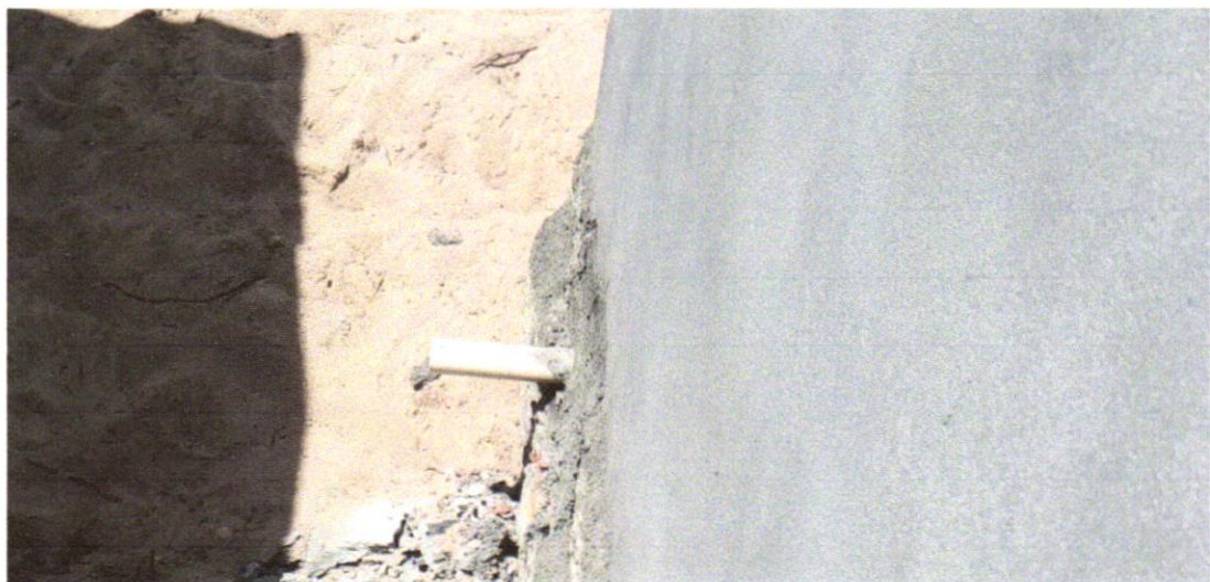
FOTO 14 - (COMPOSIÇÃO REPRESENTATIVA) DO SERVIÇO DE INSTALAÇÃO DE TUBOS DE PVC, SÉRIE R, ÁGUA PLUVIAL, DN 75 MM (INSTALADO EM RAMAL DE ENCAMINHAMENTO, OU CONDUTORES VERTICAIS), INCLUSIVE CONEXÕES, CORTE E FIXAÇÕES, PARA PRÉDIOS. AF_10/2015
