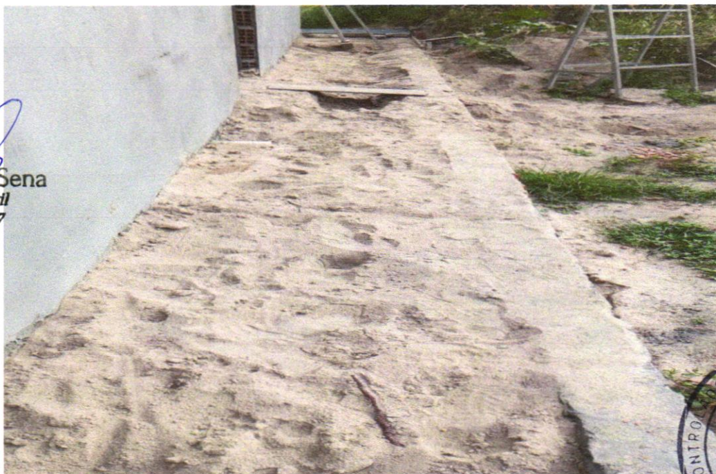
FOTO 04 -ATERRO MANUAL DE VALAS COM AREIA PARA ATERRO E COMPACTAÇÃO MECANIZADA. AF_05/2016
