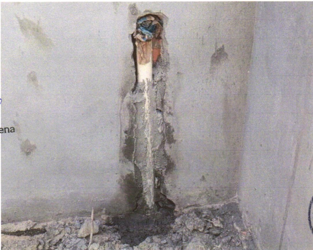
FOTO 08 – (COMPOSIÇÃO REPRESENTATIVA) DO SERVIÇO DE INSTALAÇÃO DE TUBOS DE PVC, SÉRIE R, ÁGUA PLUVIAL, DN 75 MM (INSTALADO EM RAMAL DE ENCAMINHAMENTO, OU CONDUTORES VERTICAIS), INCLUSIVE CONEXÕES, CORTE E FIXAÇÕES, PARA PRÉDIOS. AF_10/2015
