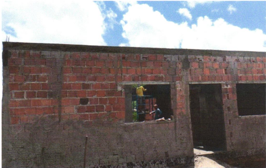
FOTO 13 - (COMPOSIÇÃO REPRESENTATIVA) EXECUÇÃO DE ESTRUTURAS DE CONCRETO ARMADO, PARA EDIFICAÇÃO HABITACIONAL UNIFAMILIAR TÉRREA (CASA EM EMPREENDIMENTOS), FCK = 25 MPA. AF_01/2017
