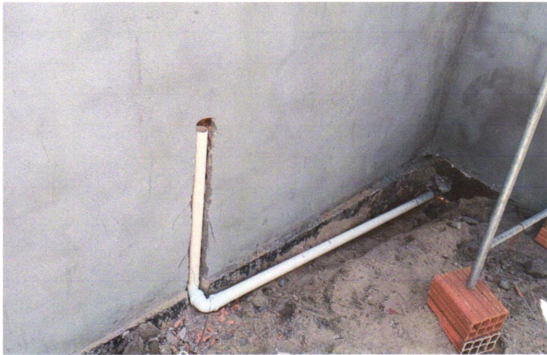
FOTO 09 - (COMPOSIÇÃO REPRESENTATIVA) DO SERVIÇO DE INSTALAÇÃO DE TUBOS DE PVC, SÉRIE R, ÁGUA PLUVIAL, DN 75 MM (INSTALADO EM RAMAL DE ENCAMINHAMENTO, OU CONDUTORES VERTICAIS), INCLUSIVE CONEXÕES, CORTE E FIXAÇÕES, PARA PRÉDIOS. AF_10/2015
